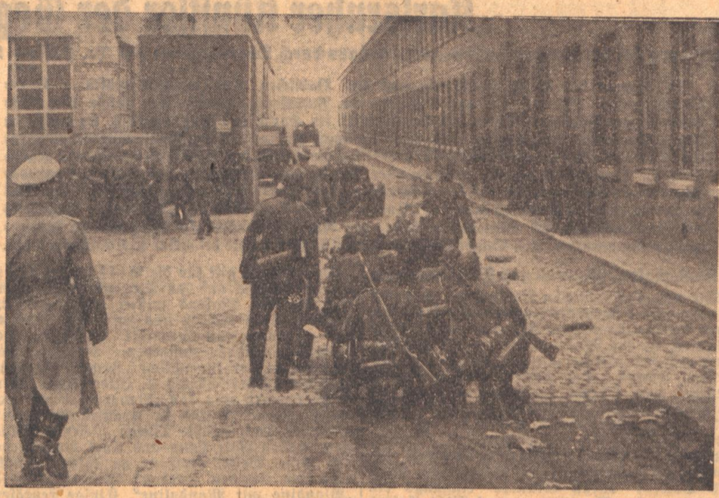
Straßenkämpfung am Atlantikwall. Der gewaltige Atlantikwall ist kein toter Mechanismus. Seine riesigen Befestigungsanlagen sind besetzt durch eine glänzend geschulte Truppe...
