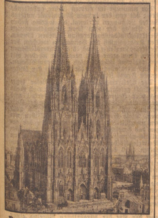
Der Kölner Dom, eines der großartigsten Bauwerke in deutscher Hochgotik.
