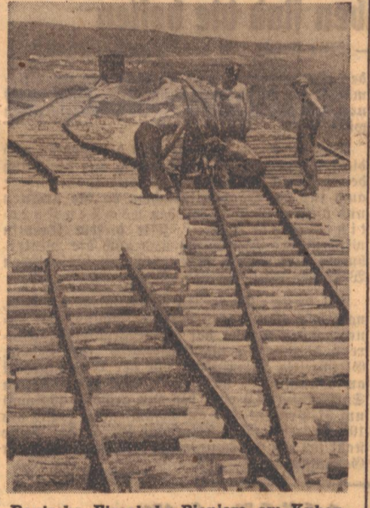
Deutsche Eisenbahn-Pioniere am Kuban. In 24 Stunden haben deutsche Eisenbahn-Pioniere 50 Kilometer Bahngleise von der Breitspur auf die Schmalspur unserer Feldbahnen umgestellt. Besonders an der Nacht- und Weichenstellen muß sehr sorgfältig, oft unter Zuhilfenahme des Schneidebremsens, gearbeitet werden. PK-Kriegsbericht Lange (Sch).
