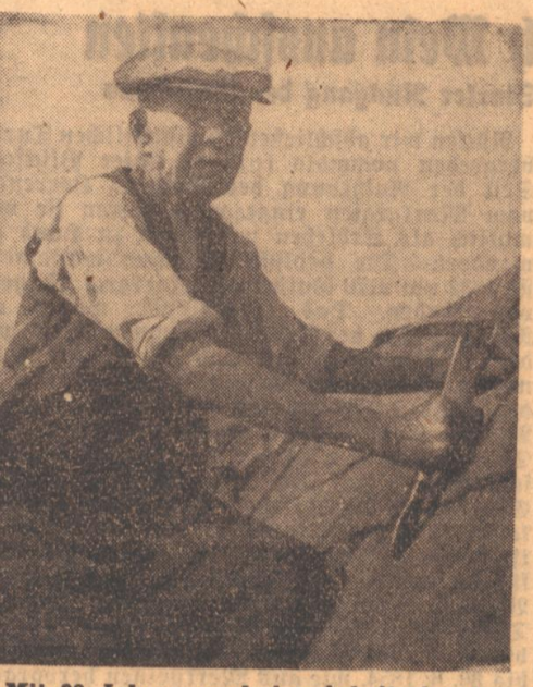
Mit 90 Jahren noch im Arbeitseinsatz. Der Schieferdeckermeister Karl Mänzel aus Altberenberg im Sudetenland ist trotz seines Alters auch heute noch wöchentlich 50 Stunden und mehr im Betrieb seines Sohnes tätig und verrichtet mit seinen 90 Jahren noch Giebelarbeiten. Scherl-Bilderdienst (Ritschel)-M.
