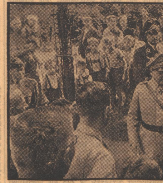
Reichsmarschall Göring besichtigt im Berliner Osten den Bau von Luftschutzgräben. Rechts vom Reichsmarschall Generaloberst Loerzer. (PK-Aufnahme: Kriegsberichterstatter Eitel Lange, HH.)
