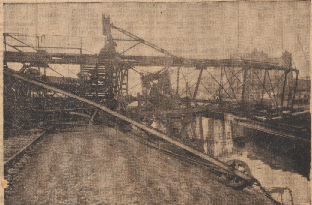
Bei einem gewaltigen Sturm im März wurde unter den Bäumen des Stadtgebietes großer Schaden angerichtet. U. a. fiel dem Sturm auch ein großer Krahn im Rheinhafen zum Opfer.
