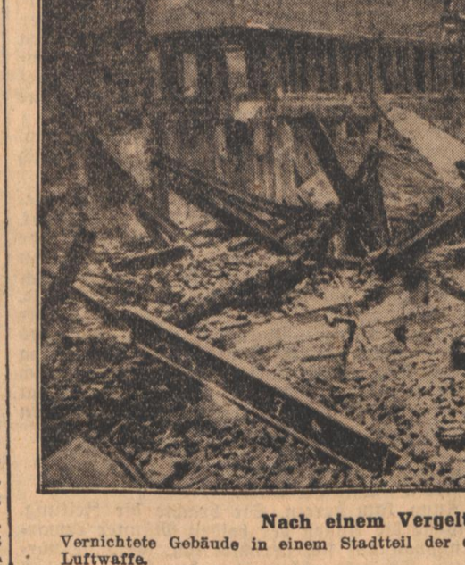
Nach einem Vergeltungsangriff auf London. Vernichtete Gebäude in einem Stadtteil der englischen City nach einem Schlag der deutschen Luftwaffe. (Scherl-Bilderdienst-M.)
