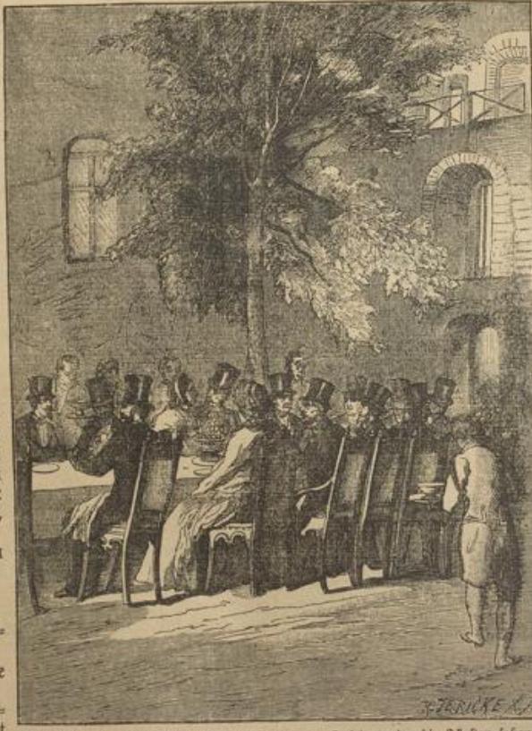
In dem reich geschmückten Schloßhof stand eine Tafel, an der die Fürsten saßen.
