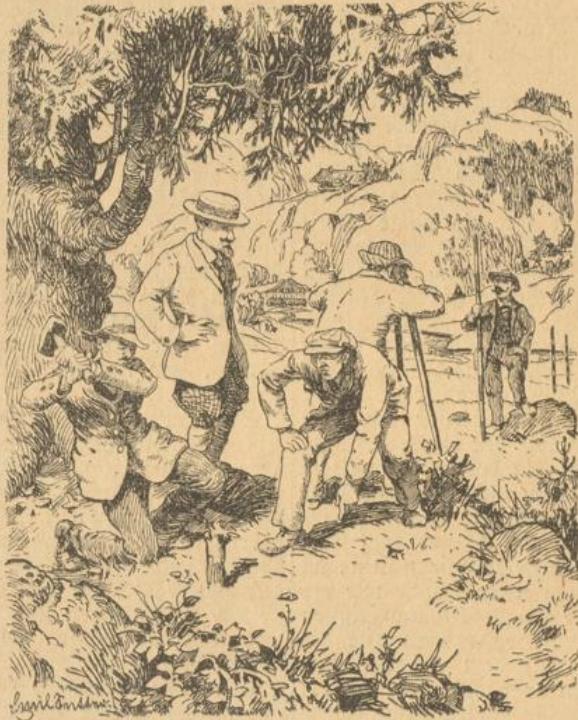
Darauf waren ein etliche Vermesser gekommen und hatten alles der Kreuz und Quere nach gemessen und voll Pflöcke und Latten gesteckt.
