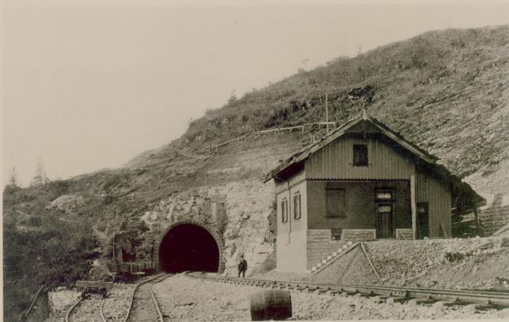
BAHNWARTSHAUS UND TUNNELPORTAL AN DER STOCKHALDE.
