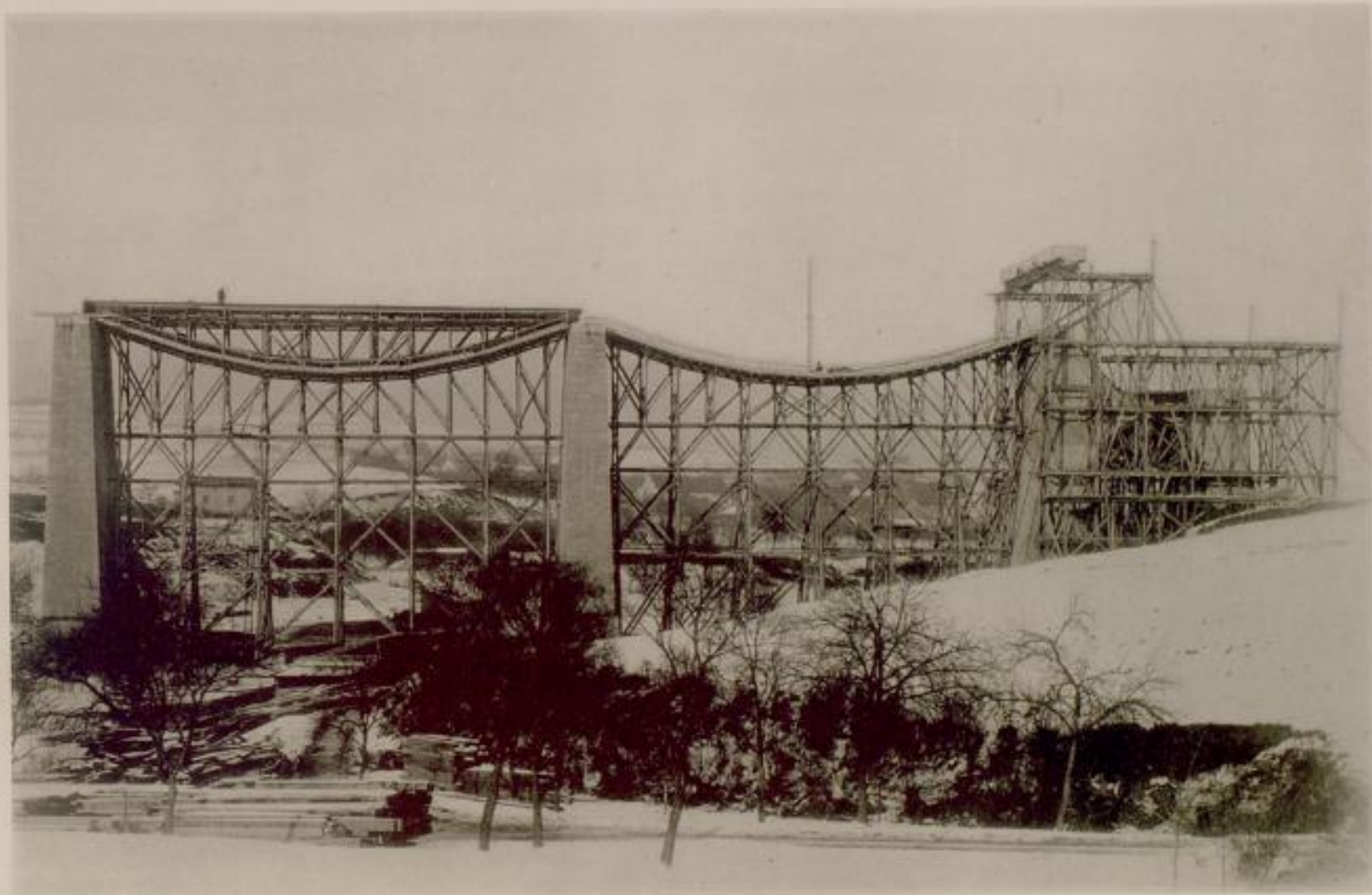
BAUGERÜST FÜR DEN THALÜBERGANG BEI FÜTZEN.
