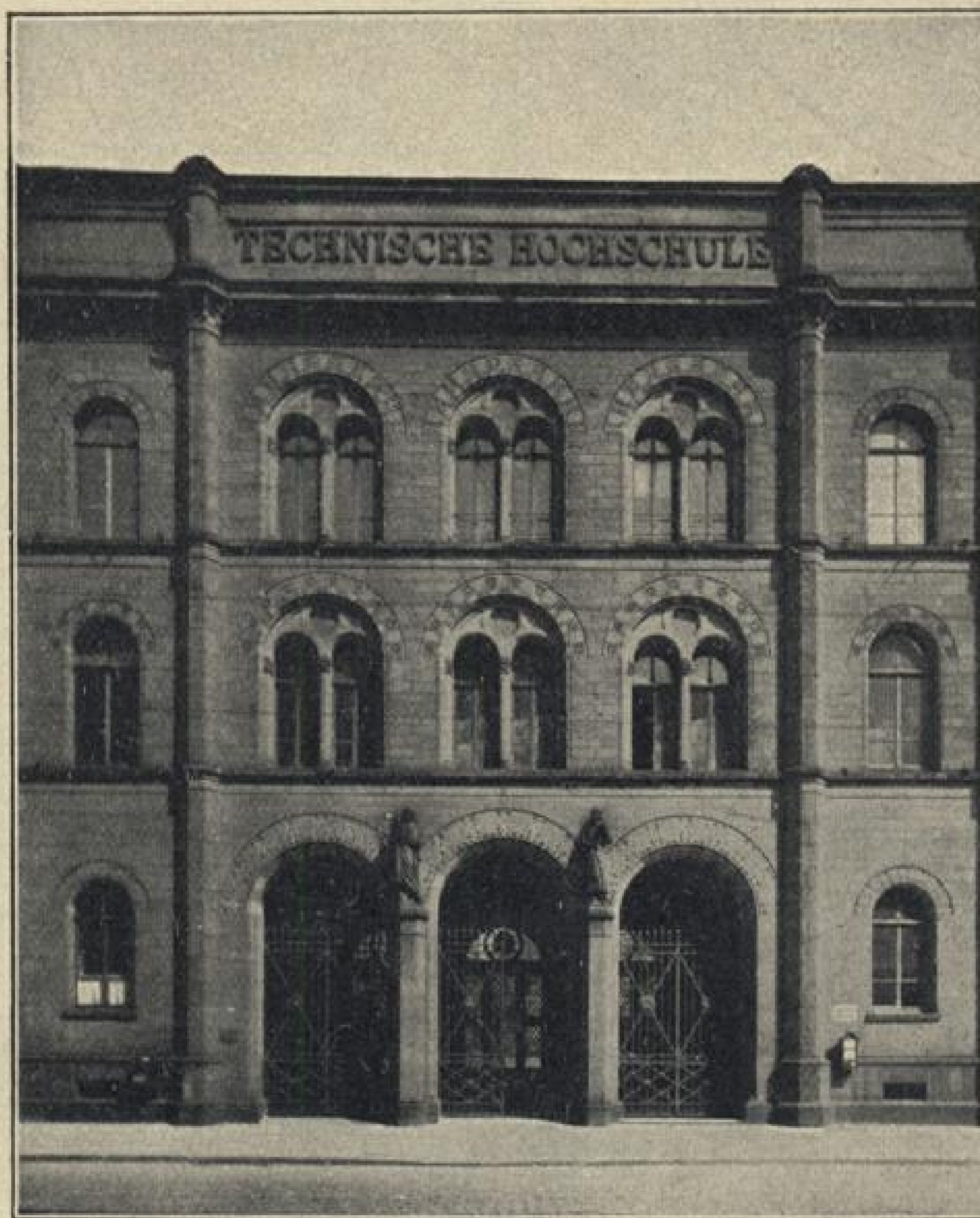
Technische Hochschule, Mittelbau.
