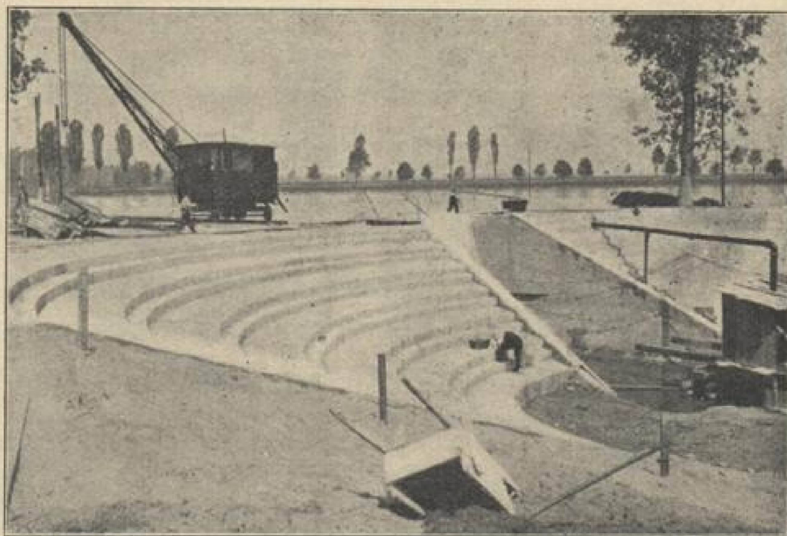
Photo: H. Rippel-Karlsruhe. Das Schwimmbaden auf Rappenwört im Bau.
