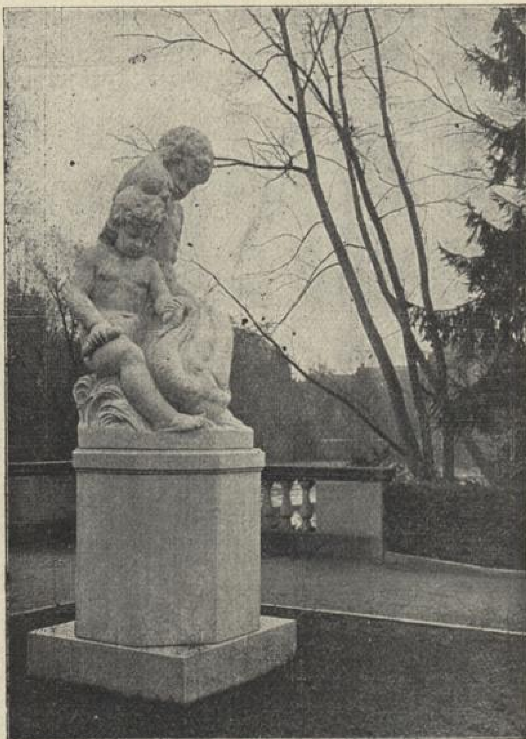
Kaller-Anlage im Stadtgarten.
