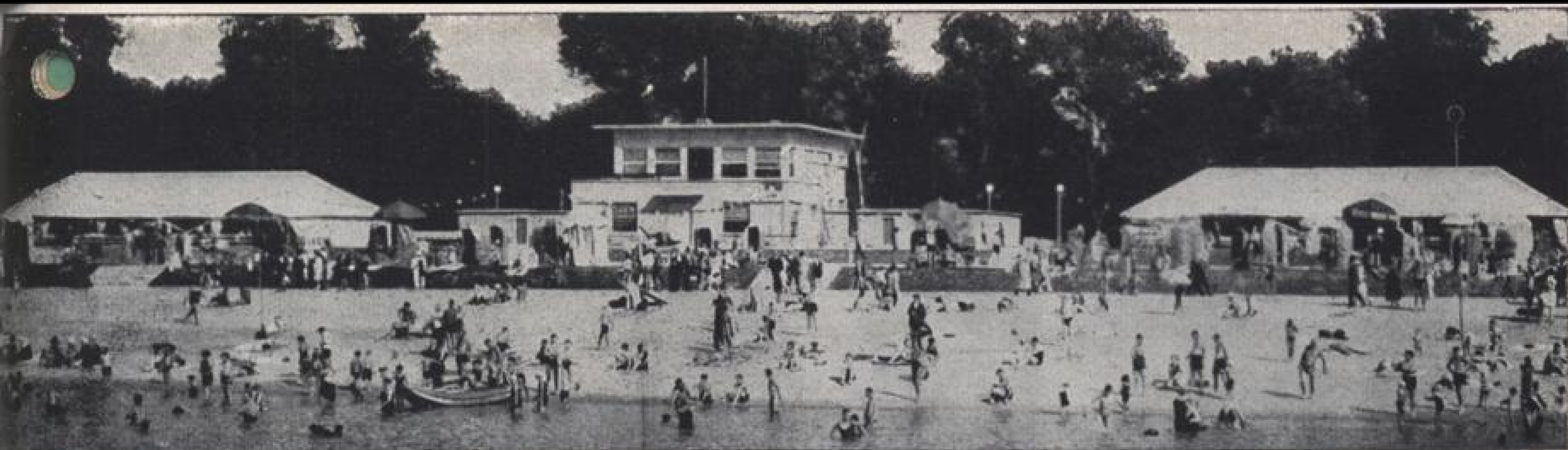
Blick auf die stilvollen Strandanlagen von Rappenwört
