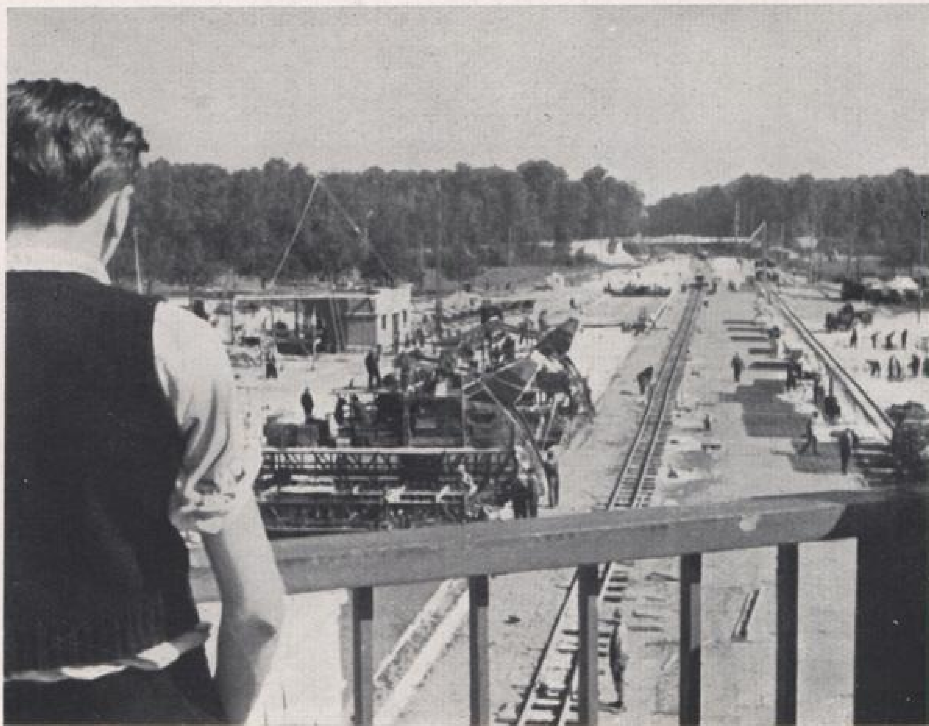
Die letzten Bauarbeiten bei der Karlsruher Reichsautobahn-Teilstrecke.
