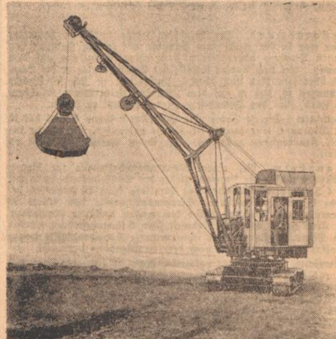
Der Raupendrehkran, ein sehr bewegliches Fördermittel
