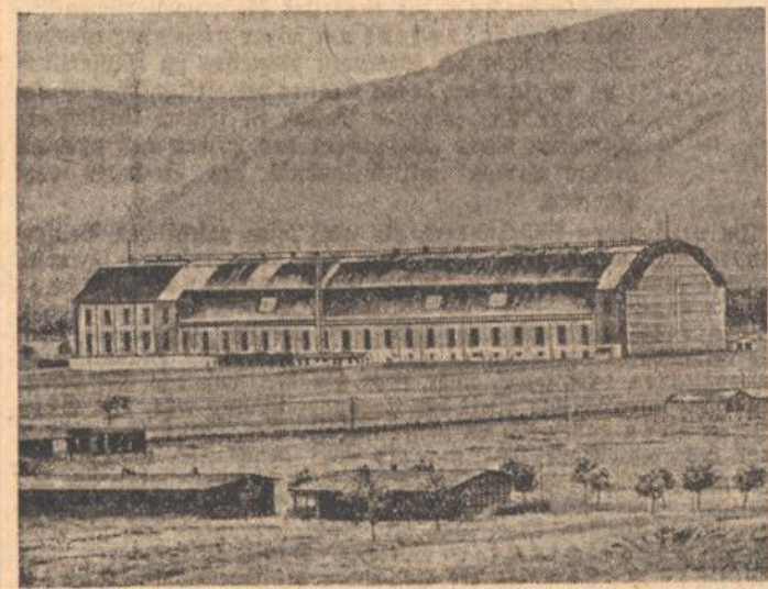
Die Zeppelinhalle auf dem Flugplatz Trier. Als mit dem Abbruch der vor wenigen Tagen fertiggestellten Zeppelinhalle in Trier begonnen werden sollte, erschienen französische Soldaten mit dem Befehl, die Abbrucharbeiten bis auf weiteres einzustellen. Die inzwischen aus Mainzheim in Trier eingetroffenen Monteur sind daraufhin unverrichteter Dinge nach Mainzheim zurückgekehrt.
