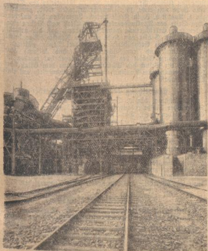
Abb. 1. Das Bild des modernen Hochofens. Charakteristisch ist der Schrägaufzug zur Küberbeschickung. Links, nahe an der Gicht, ist ein Küber erkennbar. Rechts die Winderhitzer, in denen die Gabelsluft erhitzt wird.
