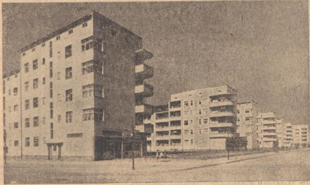
Die ersten 570 der insgesamt 1140 Wohnungen, die in dieser modernen Großsiedlung liegen
