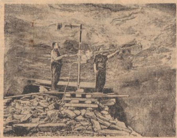
Bohrarbeit im Hangenden: Die Decke der etwa 70 m langen und 30 m breiten Räume, aus denen das Salz gefördert wird, wird durch Sprengarbeit erhöht. Der leergeforderte Raum wird durch Versatzmaterial nahezu völlig ausgefüllt und dann nach oben ermetert.
