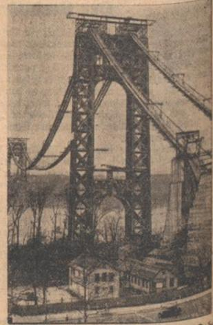
In mächtigen Bögen stützen sich die Raster von Ufer zu Ufer. Von der Raimauer (rechts) aus wird später dann die Fahrbahn ausgelegt.
