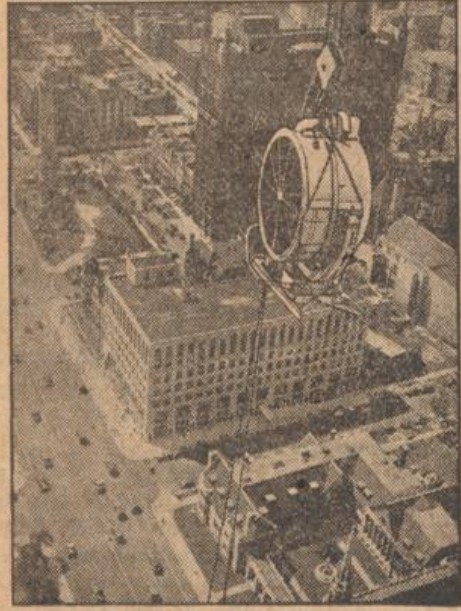
(Oben) Eine Aufnahme, die die Größenverhältnisse erkennen läßt. (Unten) Montage des Montrescheinwerfers auf dem Palmolive-Wolkenkratzer in Newyork.
