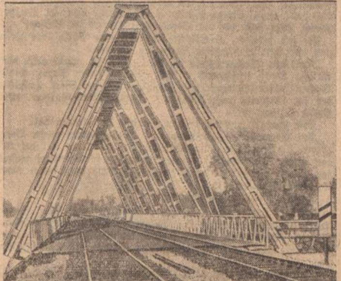
Die erste Dreigurtbrücke der Welt in Düren (Ruhr) Die 78 Meter lange Brücke über die Ruhr bei Düren.
