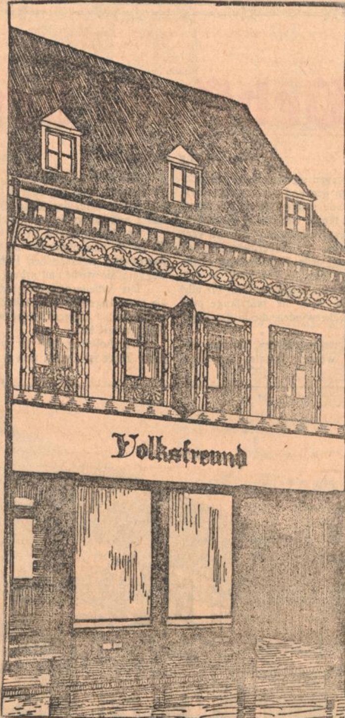
Unser Vordergebäude in der Waldstraße
