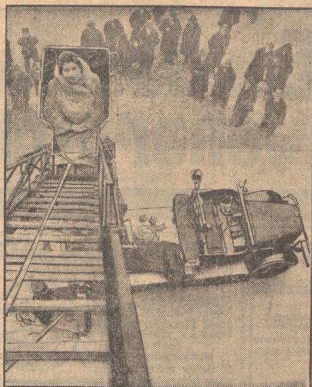
Neuartiges Rettungsmittel der Feuerwehr. Der neue Rettungskorb der Berliner Feuerwehr. Der Korb wird auf die mechanische Leiter montiert und gleitet so aus den brennenden Räumen ins Freie.
