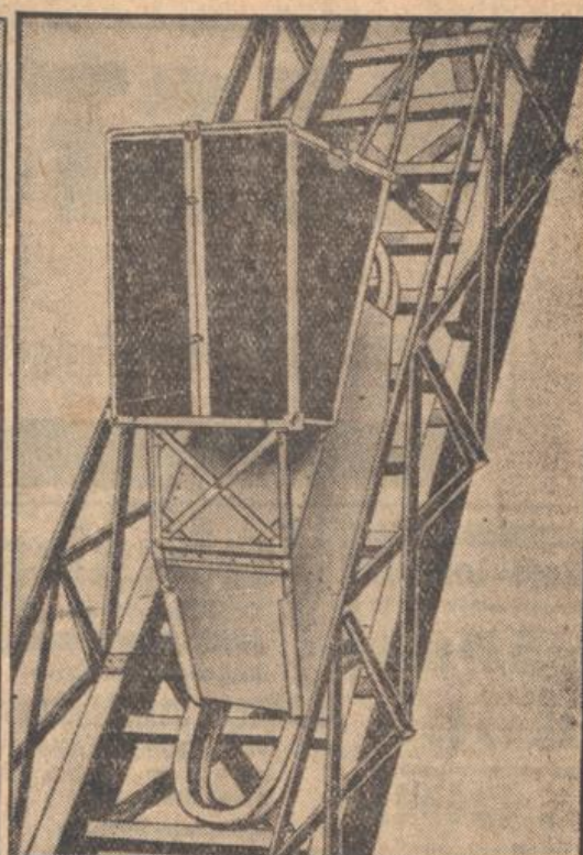
Neuartiges Rettungsmittel der Feuerwehr. Der neue Rettungskorb der Berliner Feuerwehr. Der Korb wird auf die mechanische Leiter montiert und gleitet so aus den brennenden Räumen ins Freie.
