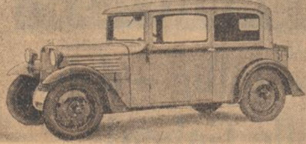
Der „Kleine Stoewer“ mit Vorderradantrieb und Schwingachsen, 1,2 Liter, 25 PS.
