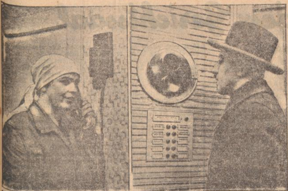
Das Hauslärtnelchen, eine neue Sicherheitsanlage. Links der Apparat in der Wohnung. Rechts des Besucher vor der Haustür, der nur auf den Knopf zu drücken braucht, um eine Verbindung zu bekommen.
