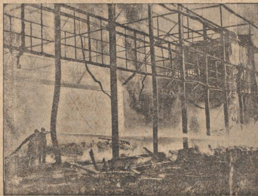
Der Großbrand im Malmöer Flughafen. Der verstärkte Hauptschuppen des Flughafens von Malmö (Schweden), der völlig niederbrannte. Eine Jantersmaschine wurde ebenfalls völlig zerstört.
