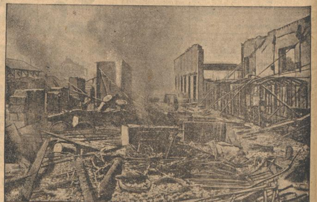
Der ausgebrannte Grenzbahnhof (Gens-Annemasse). Der an der französischen Grenze gelegene Gensler Bahnhof Annemasse wurde durch ein Großfeuer vollständig vernichtet.
