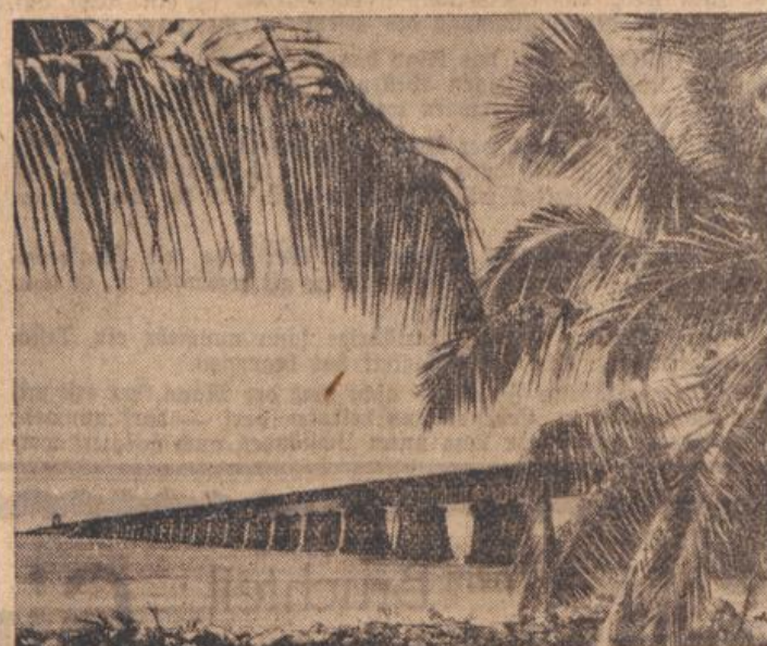
Die längste Eisenbahnbrücke über den Ozean.
