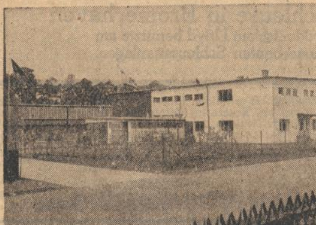
60-Morgen-Stelle; Wohnung, Stall und Scheune in einem Baukörper vereinigt, Scheune quer vorgelegt.
