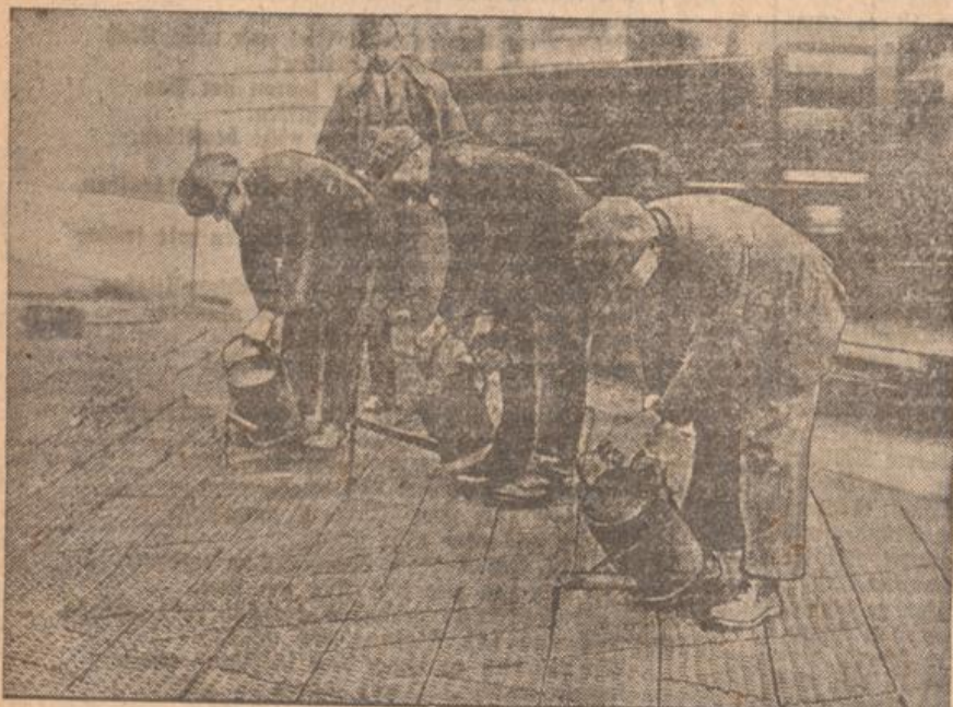
In den Straßen der Londoner Vorstadt Islington wurden Eisenplatten an Stelle des wegen seiner Glätte gefährlichen Asphalt zur Verkleinerung benutzt. Die römischen Platten sind mit einem Rastmuster versehen, das den Autoreifen Halt gibt und dieselben werden mit Teer zusammengefügt.
