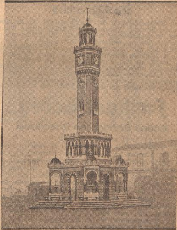
Zum Erdbeben in Smyrna Das imposante Bauwerk, der Uhrum in Smyrna, fiel dem großen Erdbebenkatastrophen zum Opfer.
