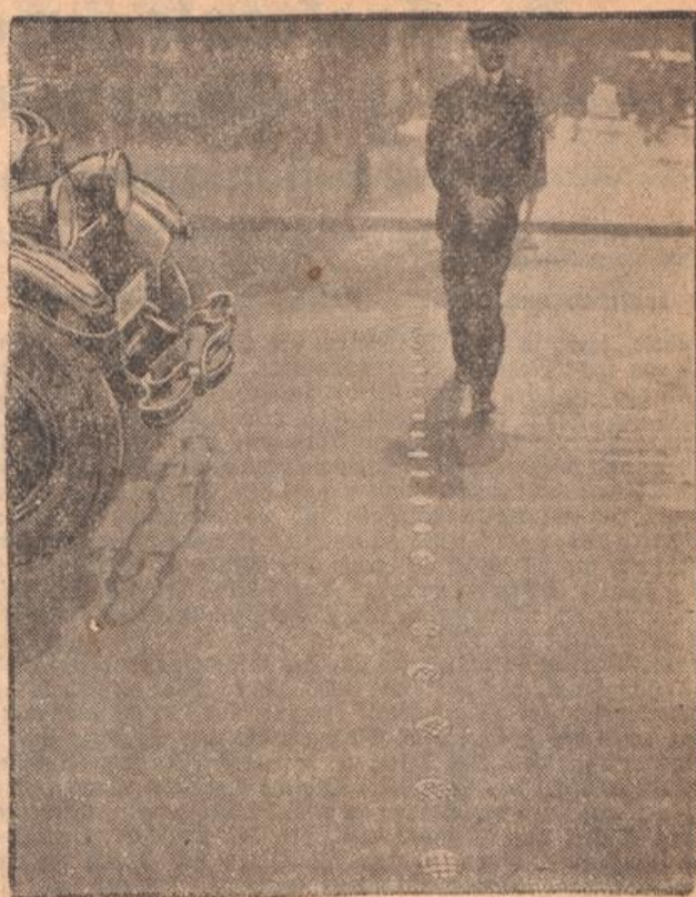
Genagelter Fahrradam. In Berlin versucht man gegenwärtig mit einer neuen Methode einen aerogelerten Verkehr einzuführen. Da sich die weißen Striche auf dem Fahrradam als Haltelinien für Fahrer als unschlüssig erwiesen haben, sind jetzt Metallnägeln in den Asphalt eingeschlagen worden. Die Nägel sind gut abgeplattet und ragen etwas heraus, sind aber für die Fahrzeuge bequem zu überfahren.
