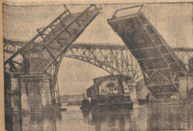
Ein amerikanischer Ingenieur hat fälschens originellen Mittels bedient, um festigkeitsgebaute Häuser von Ort zu Ort zu schaffen. Da keine Eisenbahn in der Lage war, die Gebäude aufzunehmen, wurden sie auf ein tiefes Floß gepackt und an ihren Bestimmungsort befördert.
