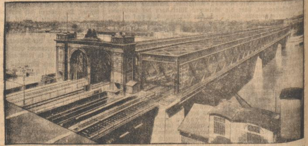
Blick auf die verbreiterte Rheinbrücke, die den Verkehr zwischen Mannheim und Ludwigshafen vermittelt. Die Brücke dient dem Fußgänger-, Auto-, Straßenbahn- und Eisenbahnverkehr
