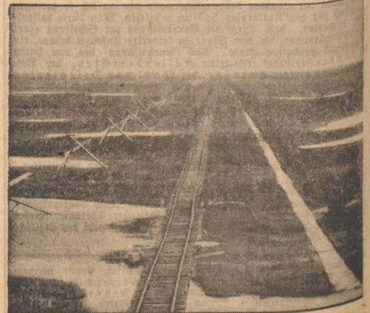
Eine Eisenbahnlinie wird übers Eis geführt. Die Schienenstraße führt 270 km weit über die fast zwei Meter tiefe Eisschicht der Hudson-Bucht
