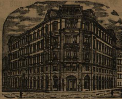
Genossenschaftsgebäude in Leipzig.
