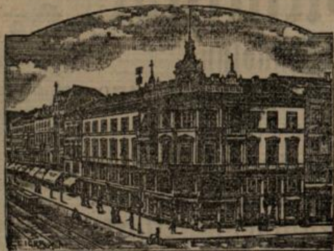
Kaiserstrasse Nr. 104, Ecke der Herrenstrasse.
