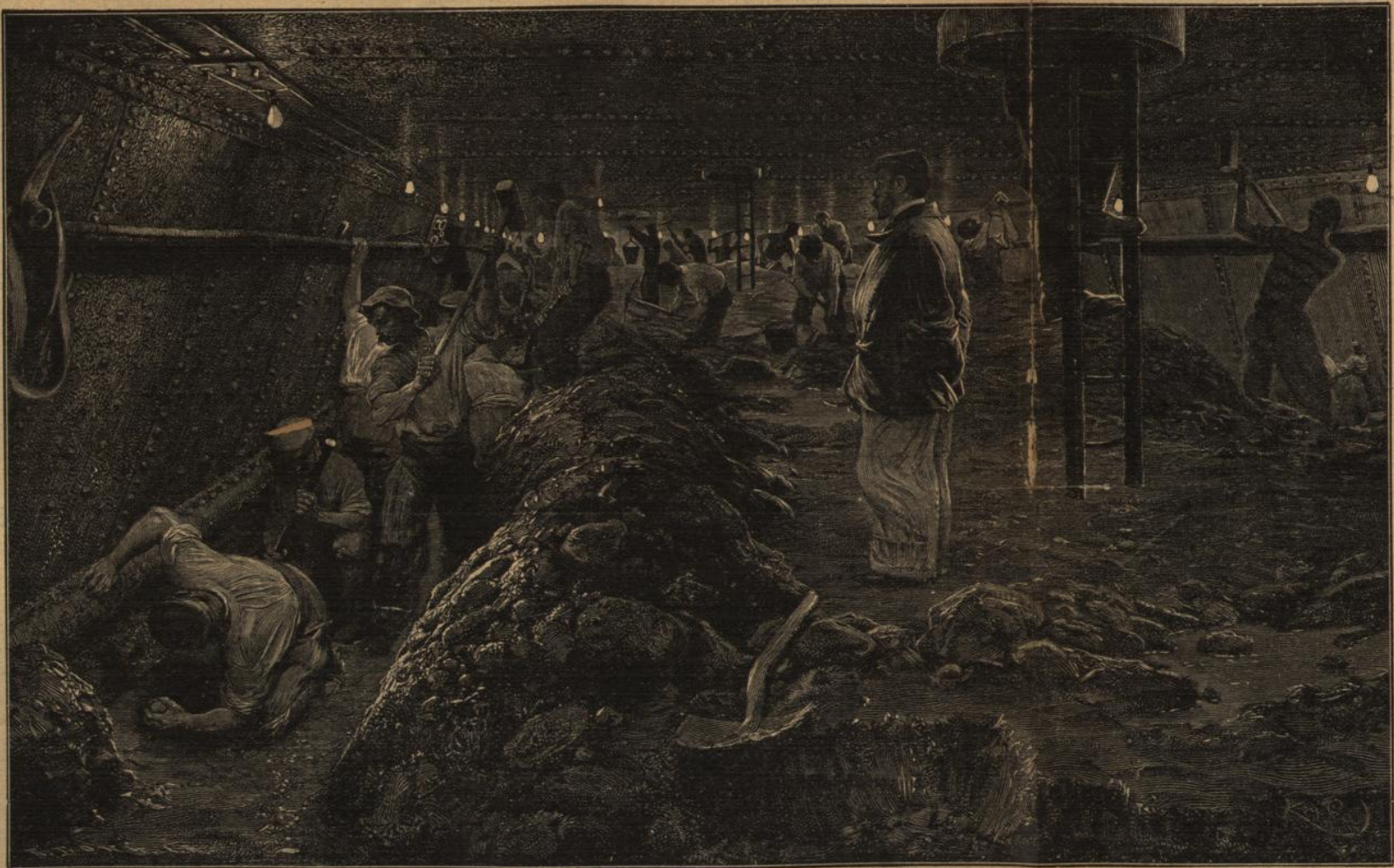
Eisen und Steine als Grundlagen des modernen Verkehrs: Tunnelbau unter dem Seineufer für die Pariser Untergrundbahn
