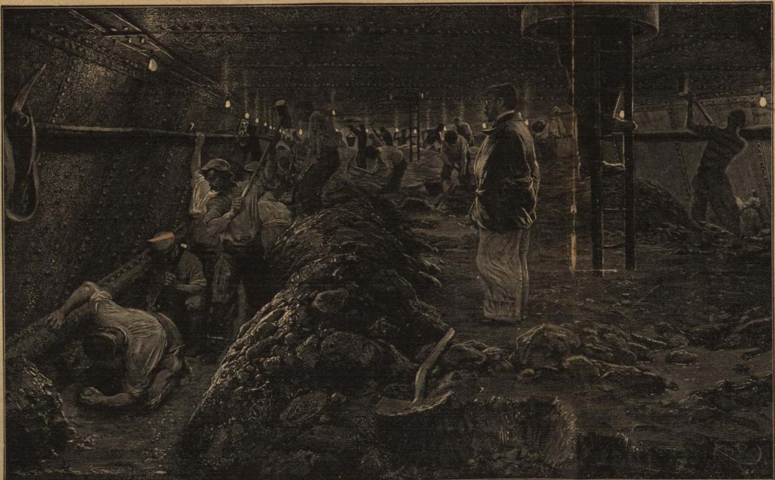
Eisen und Steine als Grundlagen des modernen Verkehrs: Tunnelbau unter dem Seineflusse für die Pariser Untergrundbahn
