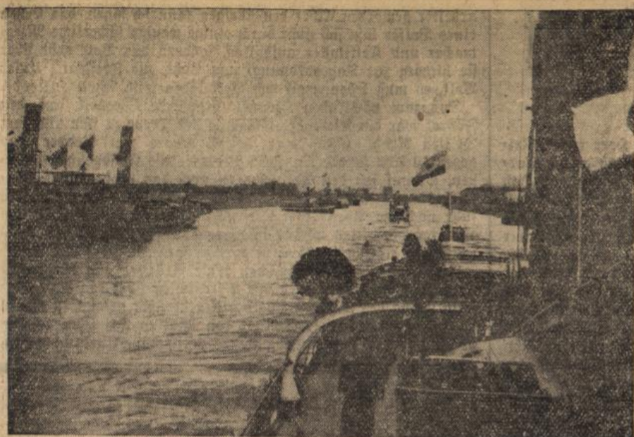
Zur Einweihung des Karlsruher Eisenkanals — Die Parade der Rheinseite
