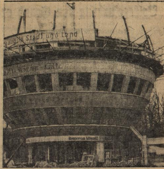
Das Dresdener Rinkelhaus wird abgerissen.
