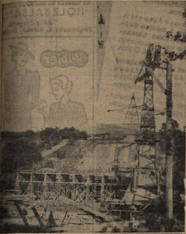
2. Die riesige Baustelle im Springer Tal bei Pforzheim
