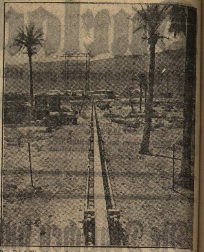
Die Iraq-Pipeline, wie die Petroleumleitung Mosul-Haifa genannt wird, ist für die Engländer deshalb von besonderer Wichtigkeit, da sie zum wesentlichen Teil die englischen Flottenstützkräfte im Mittelmeer mit Öl versorgt. So zieht sich diese Pipeline Hunderte von Kilometer durch die Wüste. (Scherl Bilderdienst-M.)
