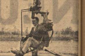
Englands neuer Kleinflugschrauber. Ein amerikanischer Techniker führt den Heliopiloten (90 km/h) vor. Die Bedienung erfolgt durch einen Hebel, den Pentecost in der Hand hält. (Dena-Inf-Bild)
