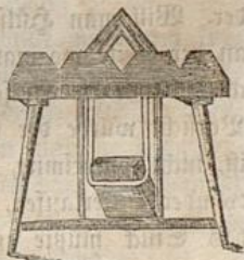
Vordere Ansicht der Windbank
