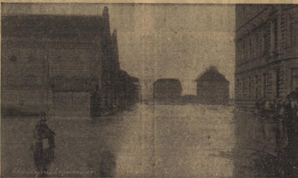
Überschwemmte Lagerhäuser im Rheinhafen
