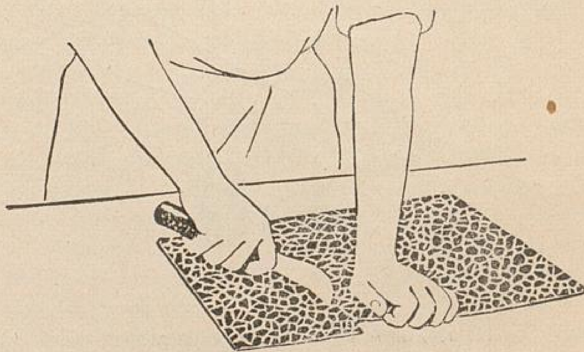
Schneiden des Linoleums mit dem Linoleummesser.
