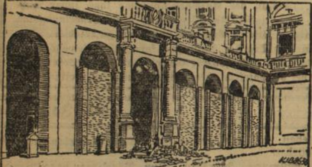
Zur Papstwahl. Beginn der Vermauerung der Zugänge zu den Konklavenräumen des Vatikans. (Zwei Zugänge sind noch nicht geschlossen.)
