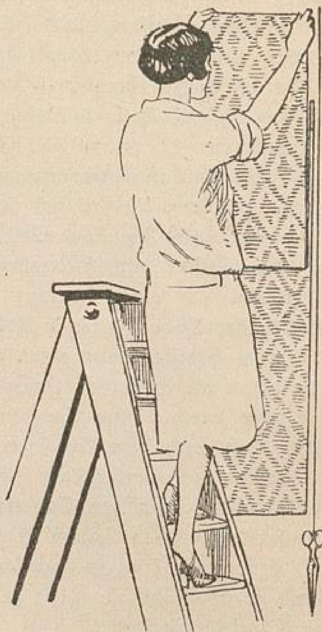
Anlegen der Tapete an die Wand, rechts die Senkschnur.
