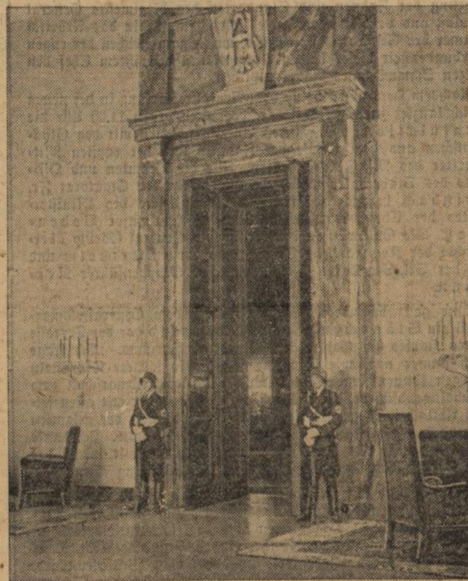
Der Eingang zum Arbeitszimmer des Führers
